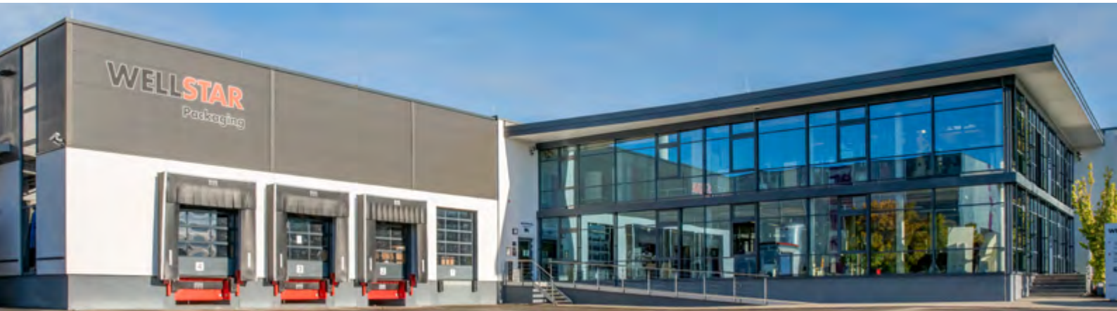
Unser Produktions- und Verwaltungsgebäude in Bräunlingen.
